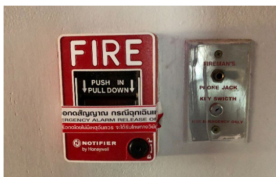
อุปกรณ์แจ้งเหตุเพลิงไหม้ด้วยมือ (Break Glass Manual Call Point)
